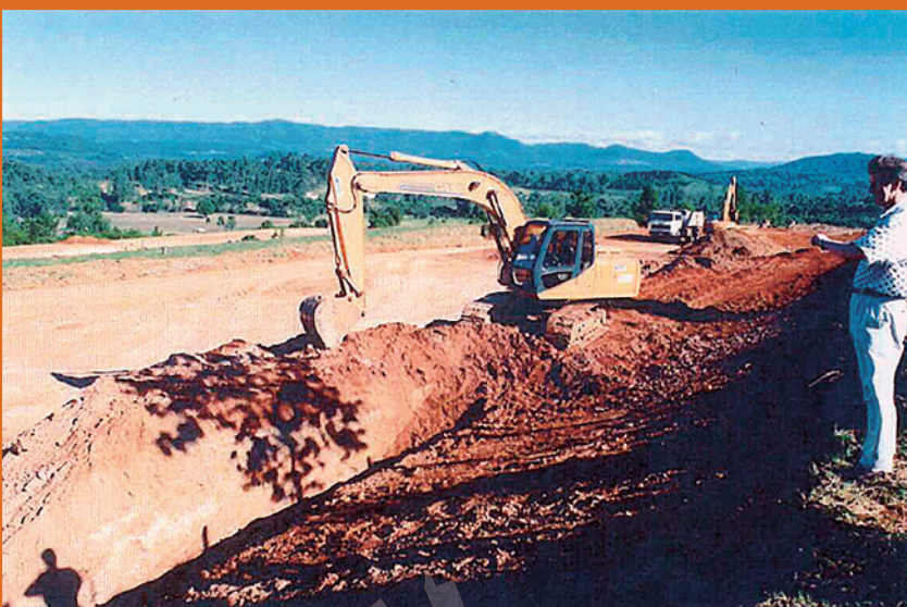
Máquinas trabalhando: início das obras foi em 18 dezembro de 1998
