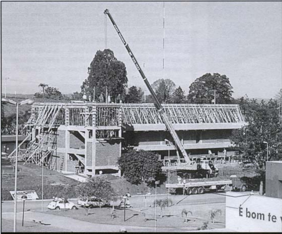
Obras estão em ritmo intenso para utilização imediata do novo espaço
