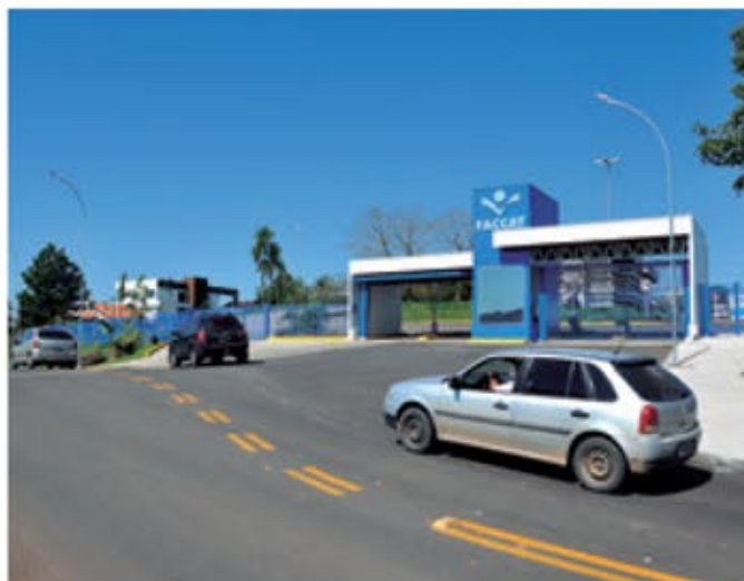
Via asfaltada liga a ERS-115 diretamente ao campus
