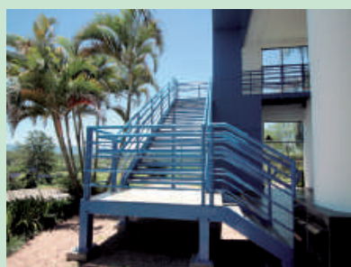
Escadas de emergência nos blocos
